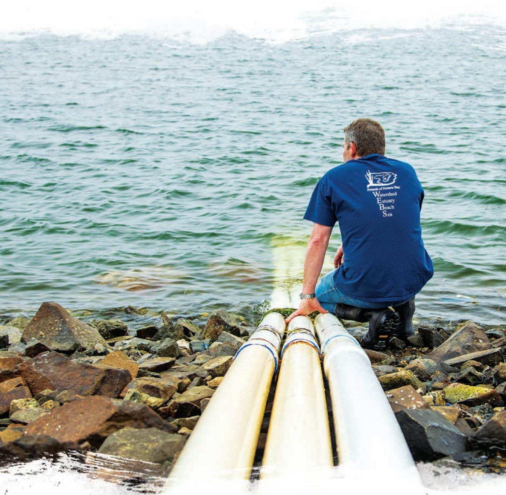
Alan Barton, gerente del criadero de mariscos de Whiskey Creek, observa la bahía de Netarts. Las tuberías extraen agua de la bahía para llenar los tanques de la planta del criadero. En el pasado, el agua se obtenía directamente de la bahía. Actualmente el criadero tiene que limpiar toda el agua que utiliza.
